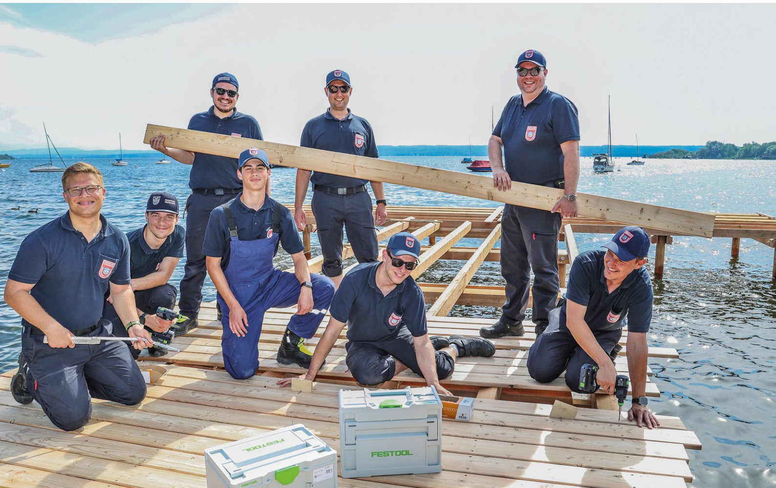
Beim Beplanken des Gemeindesteges half die Freiwillige Feuerwehr Herrsching mit neuem Werkzeug, welches die Firma Sauter aus Herrsching gespendet hat.
